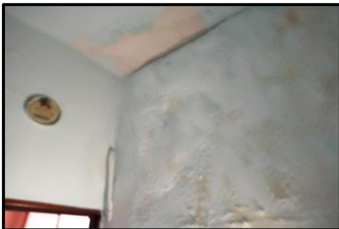
Foto n°18 - Vista del soffitto e parete del ripostiglio.
