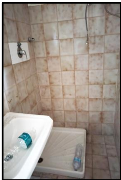
Foto n°13 – Vista del bagno.
