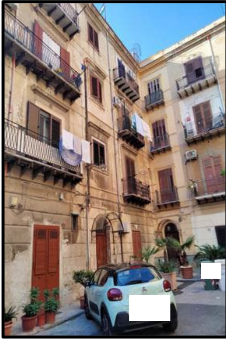
Foto n°2 - Vista del fabbricato.
