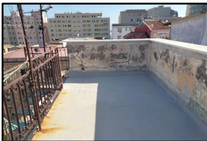
Foto n°16 – Vista del lastrico solare a terrazzo.
