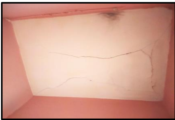
Foto n°19 - Vista del controsoffitto dell'ingresso.
