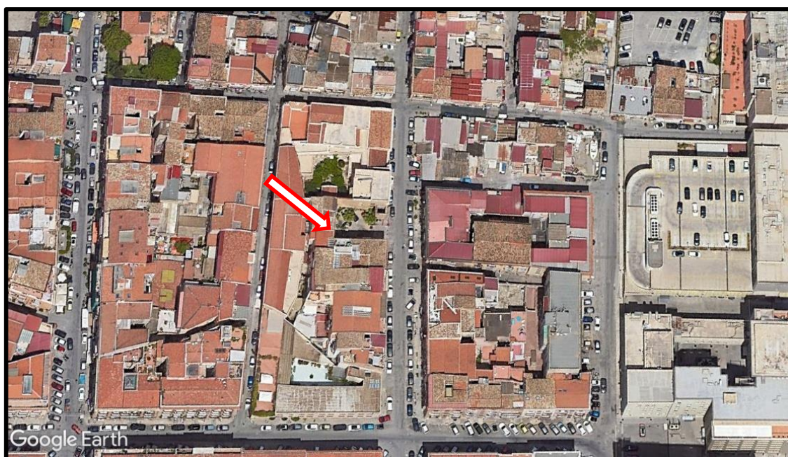
Foto n°1 – Vista aerea del fabbricato e struttura viaria.
