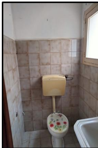
Foto n°14 – Vista del bagno.
