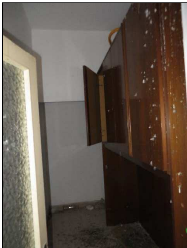
Ripostiglio al secondo piano
