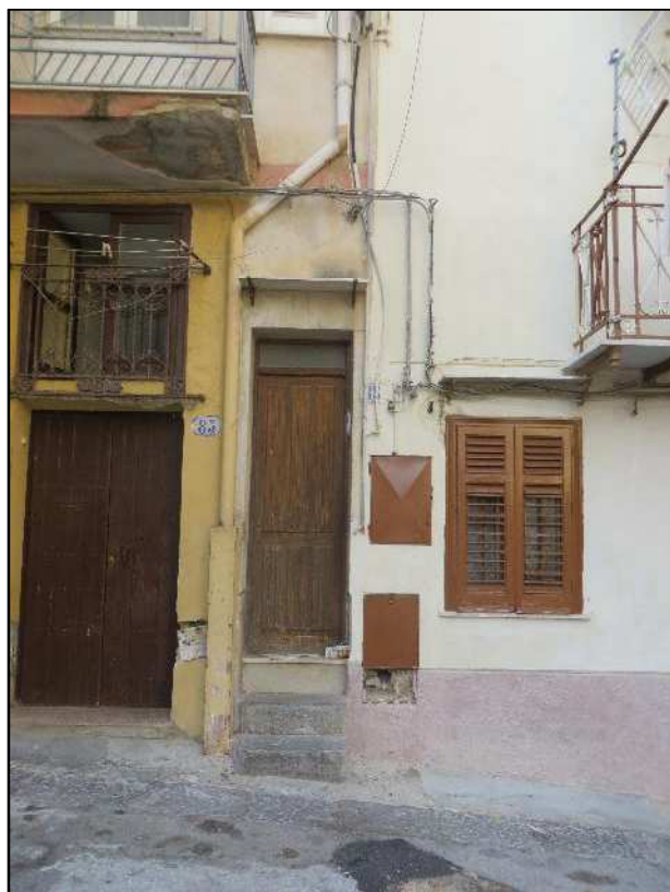
Ingresso all'unità immobiliare da via Marcianò
