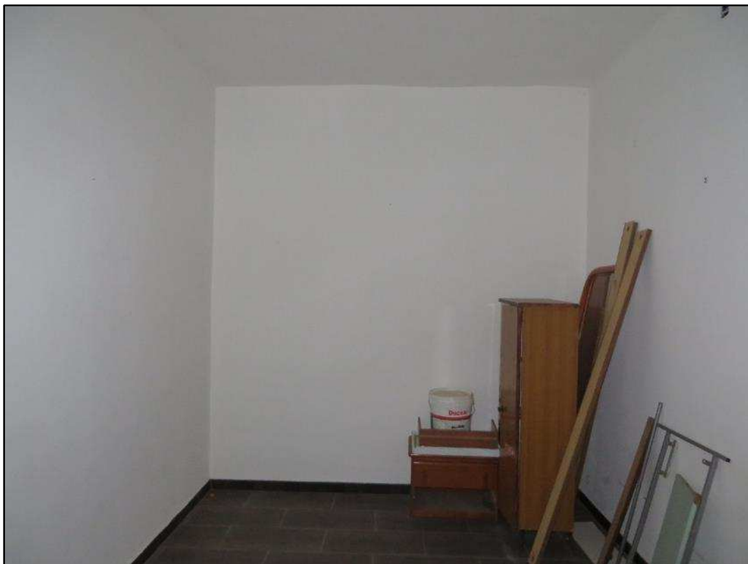
Vano privo di finestre accessibile dalla cucina
