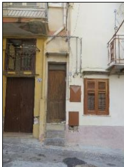
Ingresso all'unità immobiliare da via Marcianò
