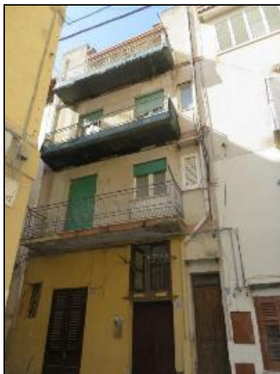
Prospetto dell'edificio su via Marcianò
