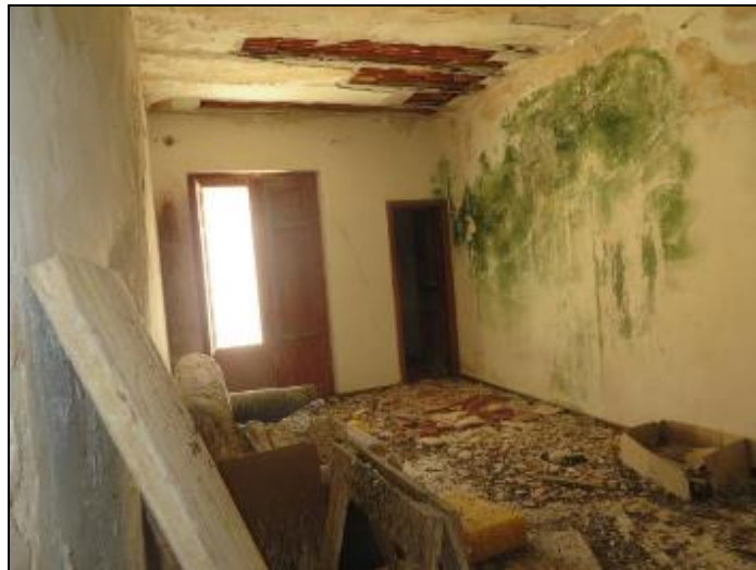
Vano al terzo piano con accesso al ripostiglio
