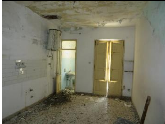
Vano al terzo piano con accesso al servizio igienico
