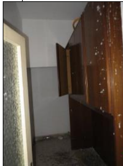
Ripostiglio al secondo piano
