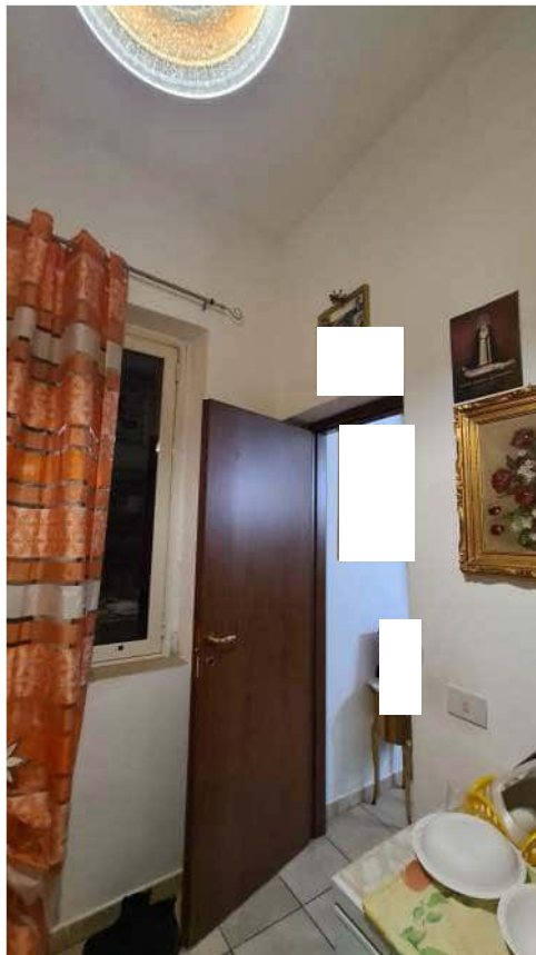
Vano porta ripostiglio
