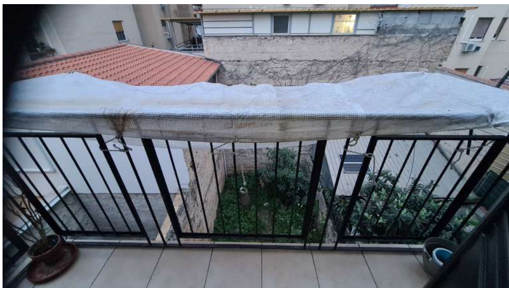
Balcone su retrospetto
