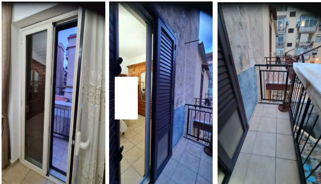
Infissi in alluminio e vetro camera dotati di persiane in alluminio
