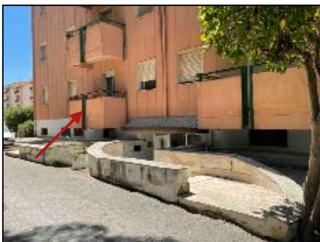
Fig.13 Accesso al corpo scala A
