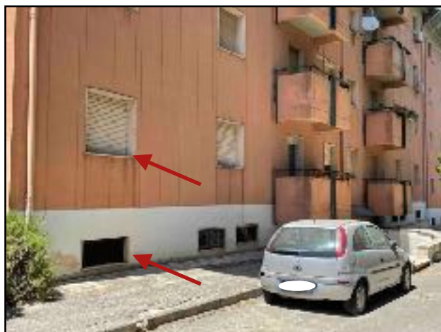
Fig.34 Appartamento e sottostante cantina
