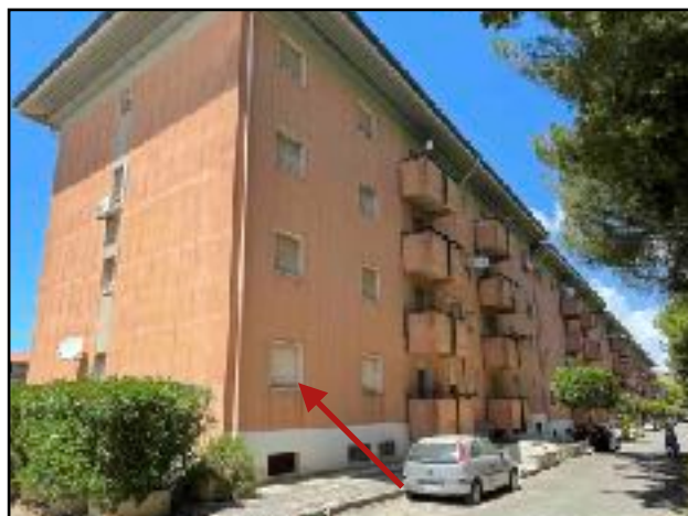
Fig.12 Fronte su via Benevento
