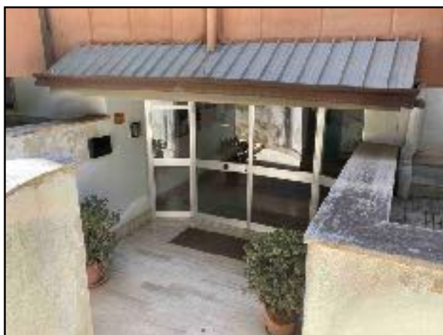
Fig.14 Accesso al corpo scala A
