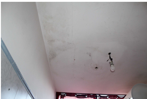
Intradosso vano w.c., piano 1°
