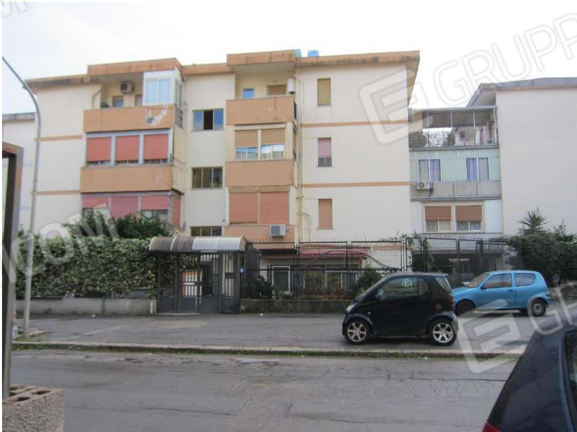
FABBRICATO AL CIVICO 56 DI VIA CENTURIPPE
