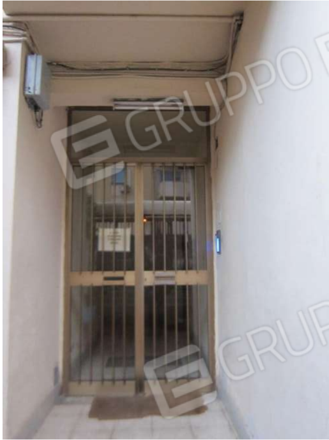
PORTONE DI INGRESSO E SCALA CONDOMINIALE
