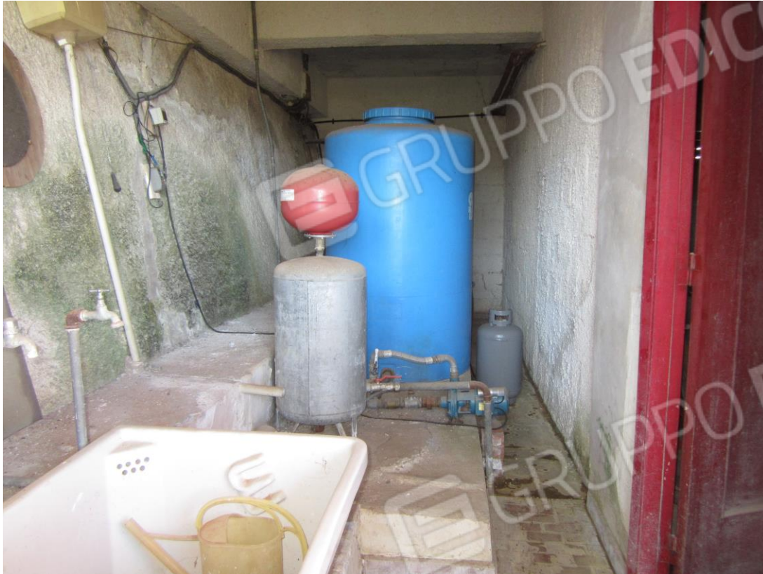
Foto 27: il vano, al piano semicantinato, che ospita la riserva idrica ed il gruppo autoclave
