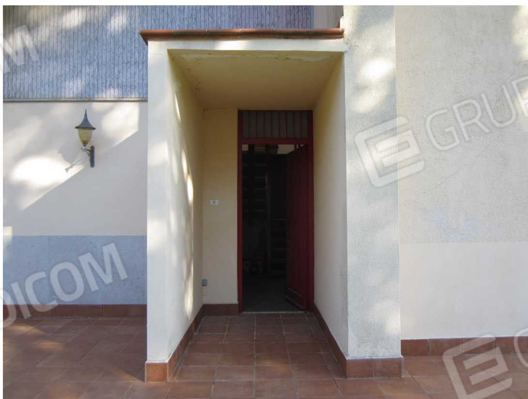
Foto 8: il portoncino di accesso al villino, che si apre sul prospetto lato sud
