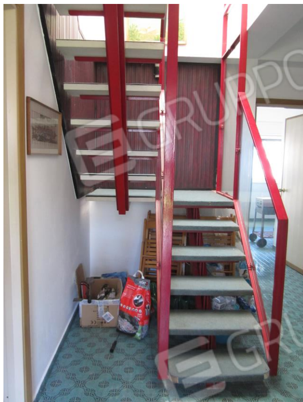
Foto 21: la scala metallica interna che conduce al piano mansarda
