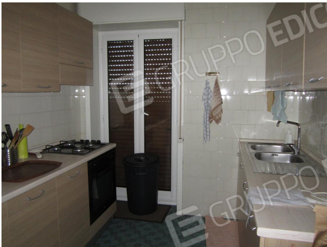
Foto 13: la cucina a destra del disimpegno cui si accede dal portoncino d'ingresso; in difformità a quanto rappresentato nel progetto in sanatoria e nella planimetria catastale, la cucina è servita da una portafinestra da cui si accede alla porzione est della terrazza
