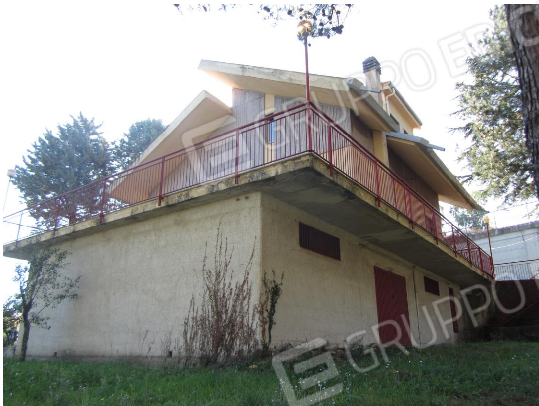
Foto 7: vista del retrospetto e del prospetto lato ovest
