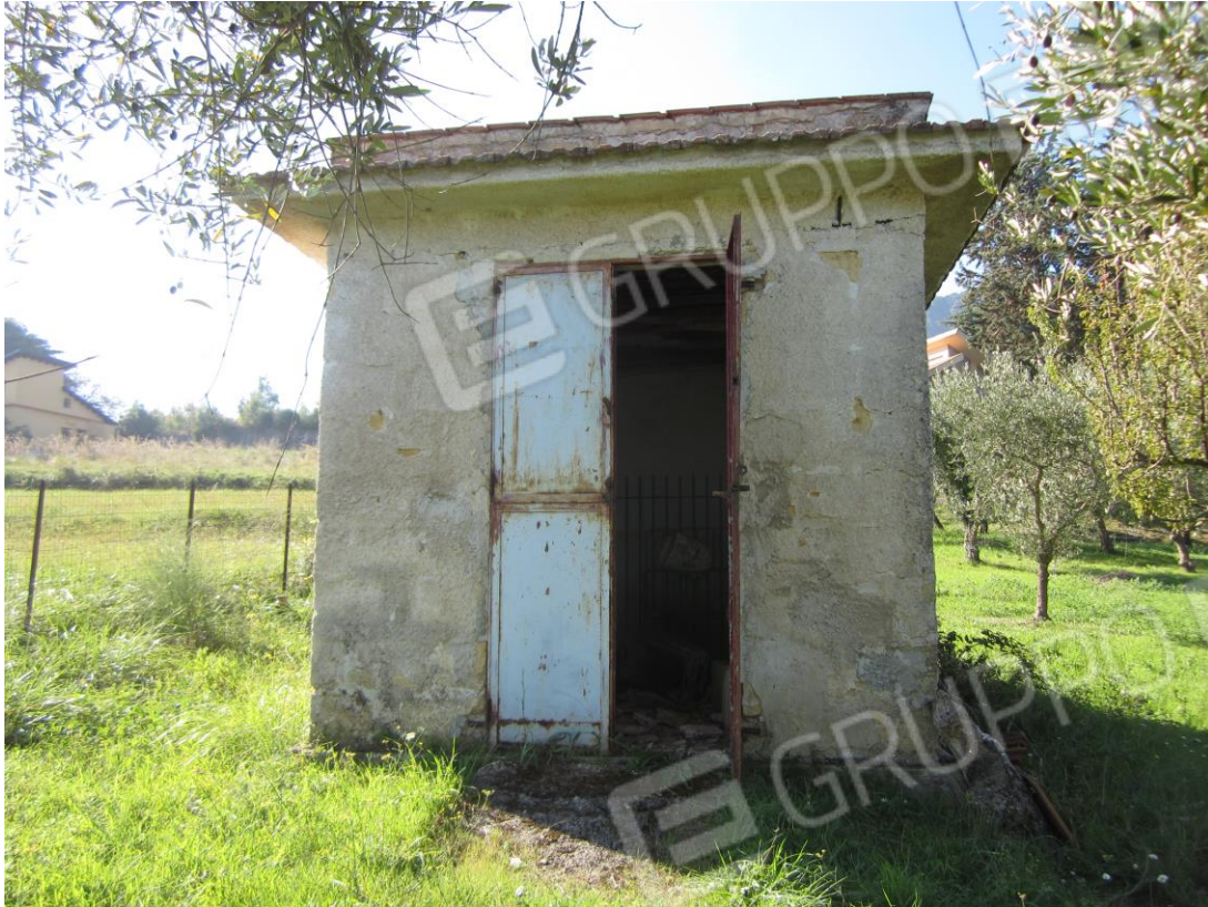
Foto 33: il manufatto, di vecchia costruzione ed in pessime condizioni di manutenzione, che insiste nel lotto di terreno identificato catastalmente, nel foglio 53 di Monreale, dalle particelle 298, 439 e 545
