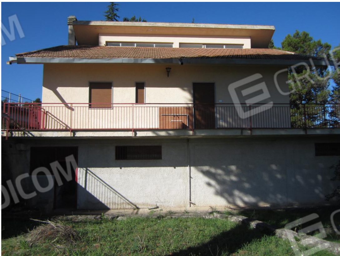
Foto 6: panoramica del prospetto lato est
