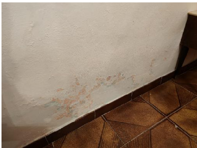
Fig. 28 efflorescenza dovuta all'umidità da risalita del terreno
