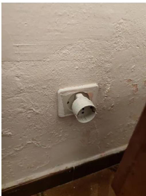
Fig. 28 efflorescenza dovuta all'umidità da risalita del terreno
