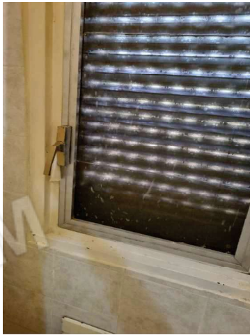
La finestra del servizio igienico
