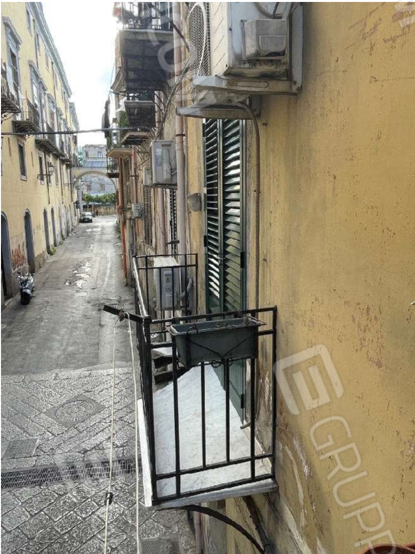
Foto n. 15 – Balconi su via S. Isidoro alla Guilla
