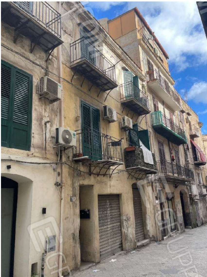
Foto n. 3 – Prospetto dell'edificio su via S. Isidoro alla Guilla
