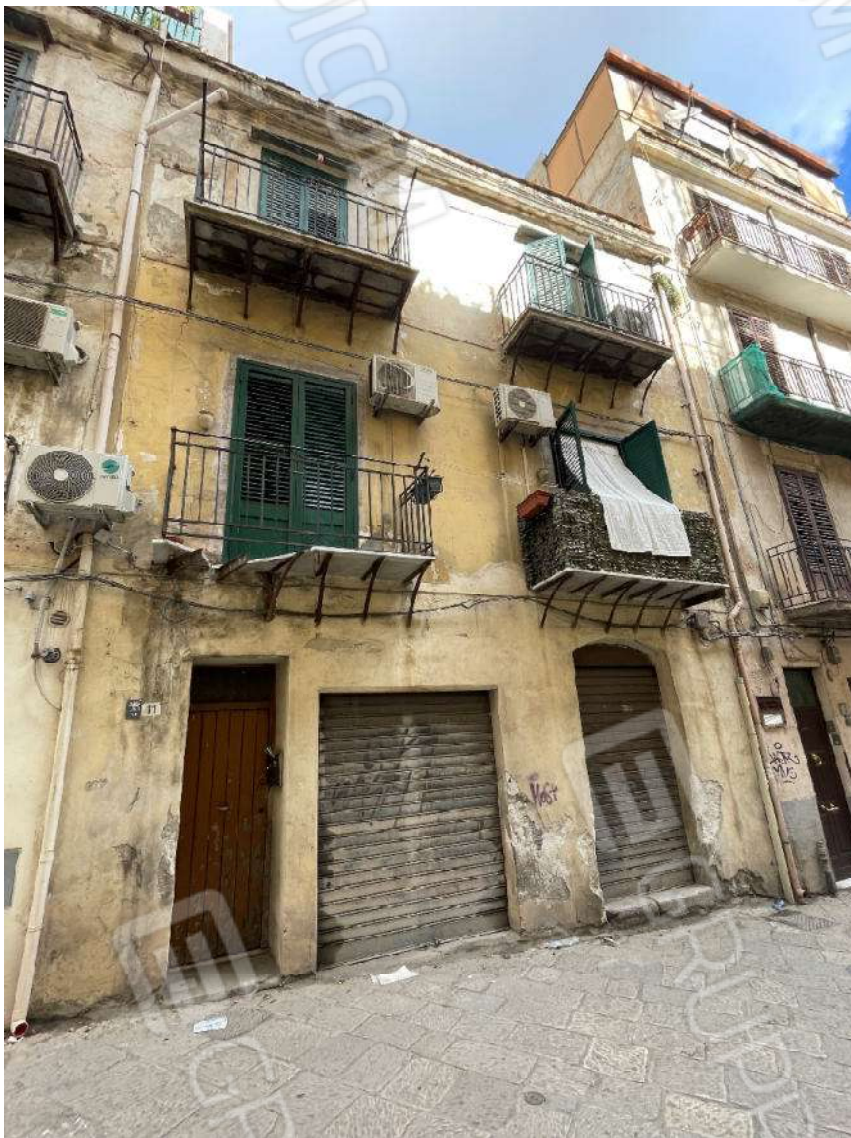
Foto n. 1 – Prospetto dell'edificio su via S. Isidoro alla Guilla
