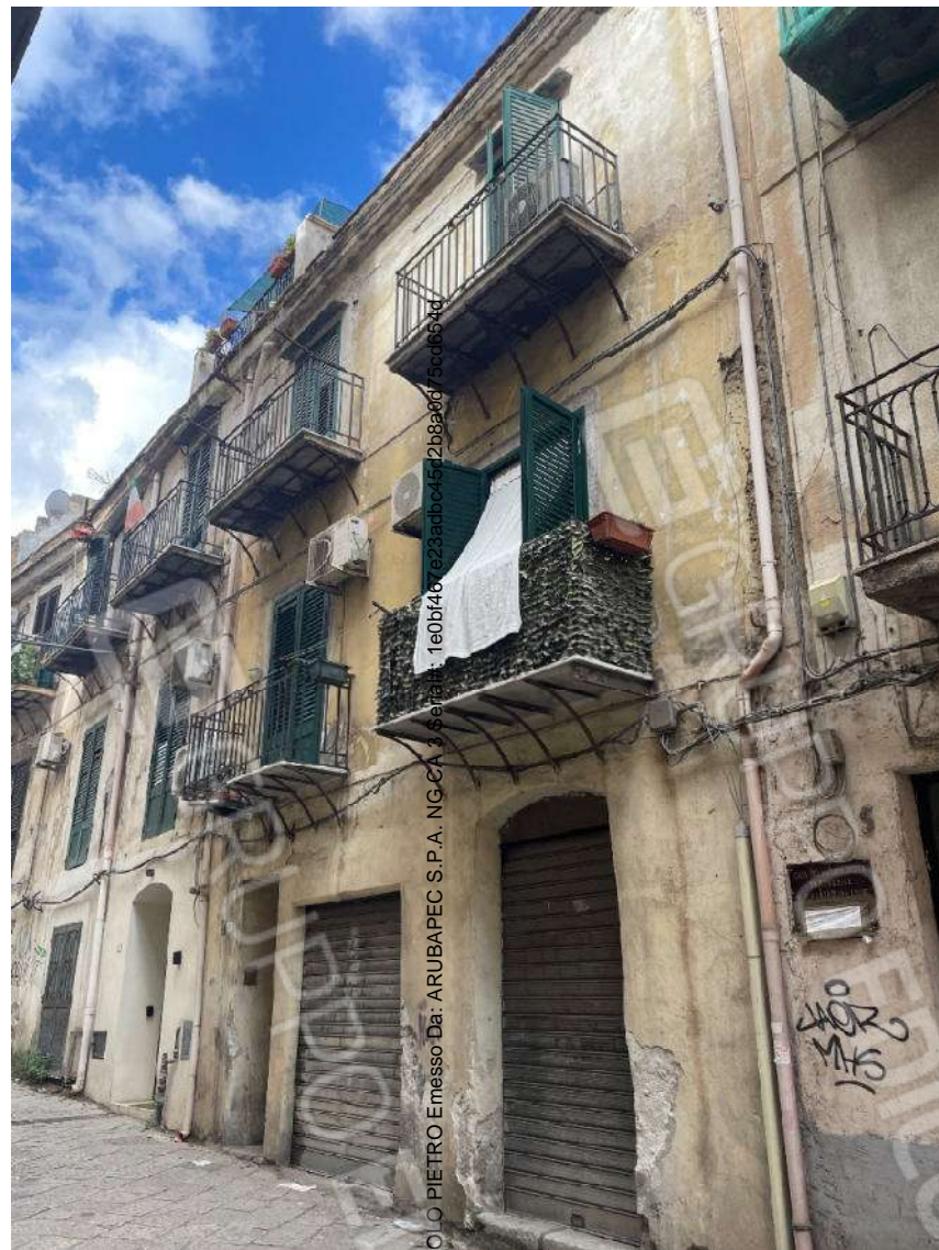
Foto n. 4 – Prospetto dell'edificio su via S. Isidoro alla Guilla
