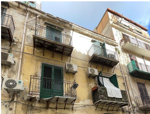
Balconi sulla via Sant'Isidoro
