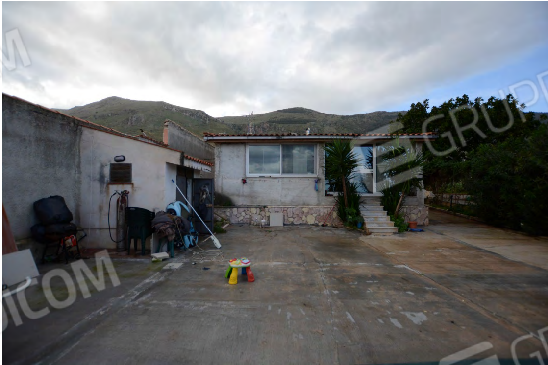
Foto 23 – u.i “A.” – Struttura in legno Villetta di Via Anversa, 20 in C.da Piraineto Carini
