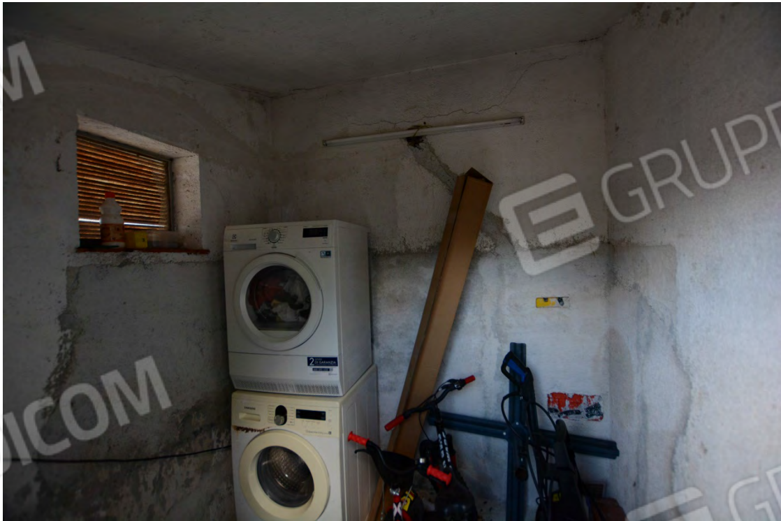
Foto 21 – u.i “A.” – Wc bagno Villetta di Via Anversa, 20 in C.da Piraineto Carini
