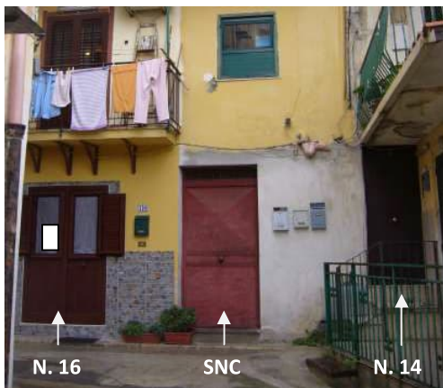
Fig. 9 Ingressi alle unità.
