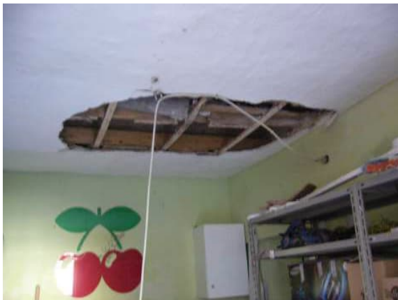
Figg. 23, 24 Particolare cedimento controsoffitto in cannucciato e gesso.
