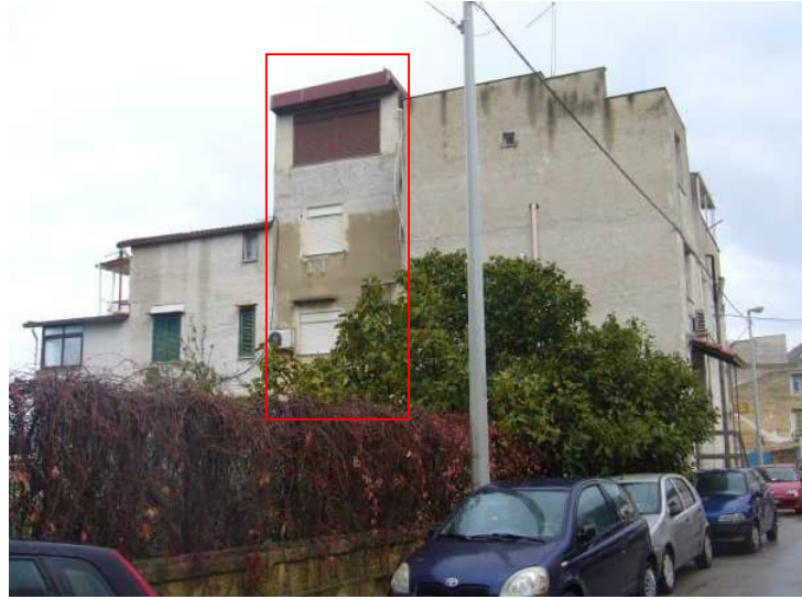
Fig. 8 Prospetto secondario in direzione sud-ovest.
