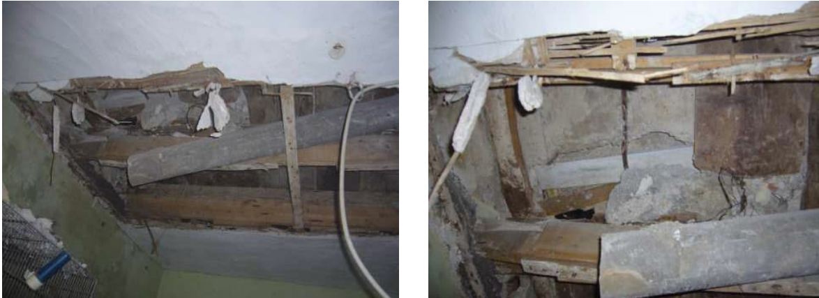
Figg. 25, 26 Particolare della struttura del solaio.
