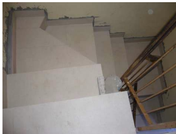
Fig. 10 Vano scala condominiale.
