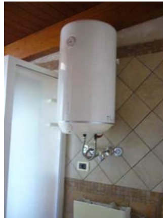
Fig. 25 Boiler elettrico.
