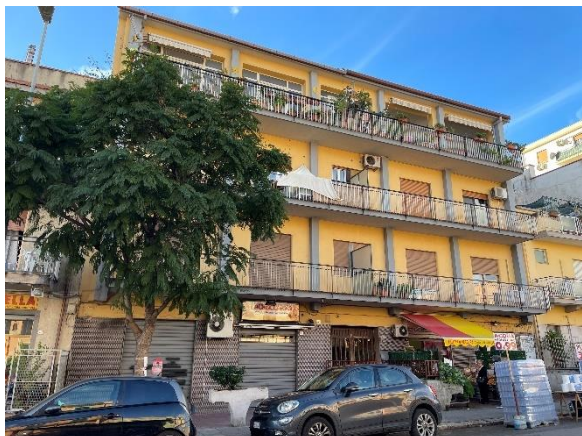
Prospetto dell'edificio su via Pitrè
