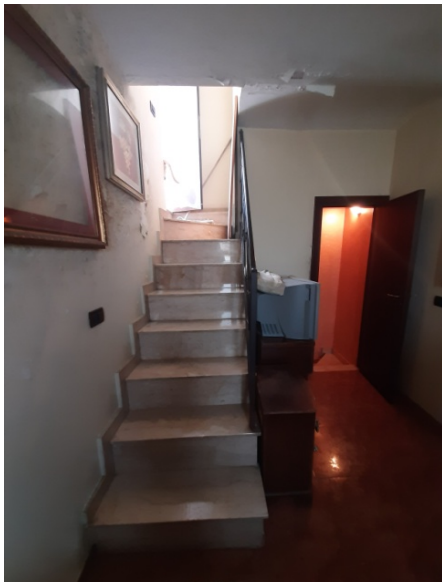
Scala di accesso alla terrazza di copertura
