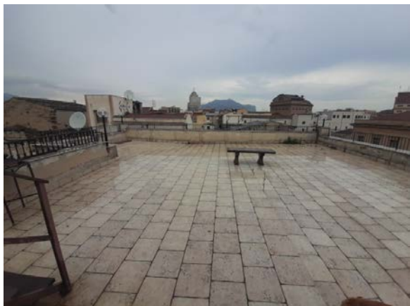
Terrazza di copertura
