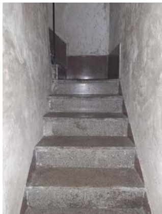
Piccolo androne e scala realizzata in muratura con intarsi marmorei
