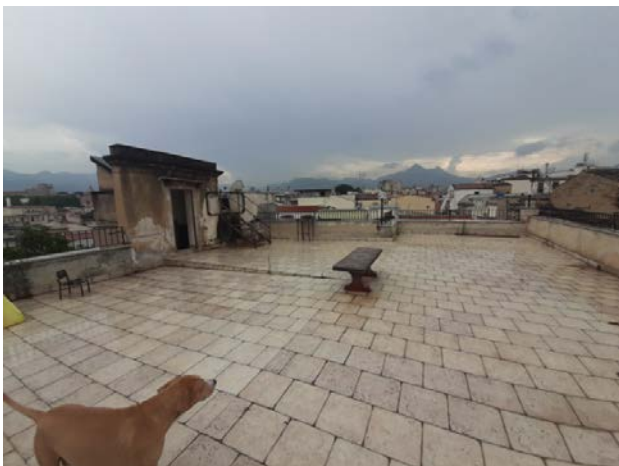
Terrazza di copertura
