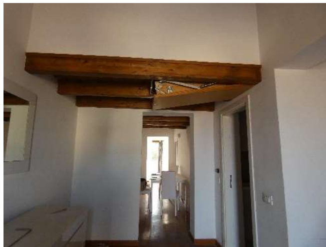
Soppalco con scala retrattile nel vano ingresso
