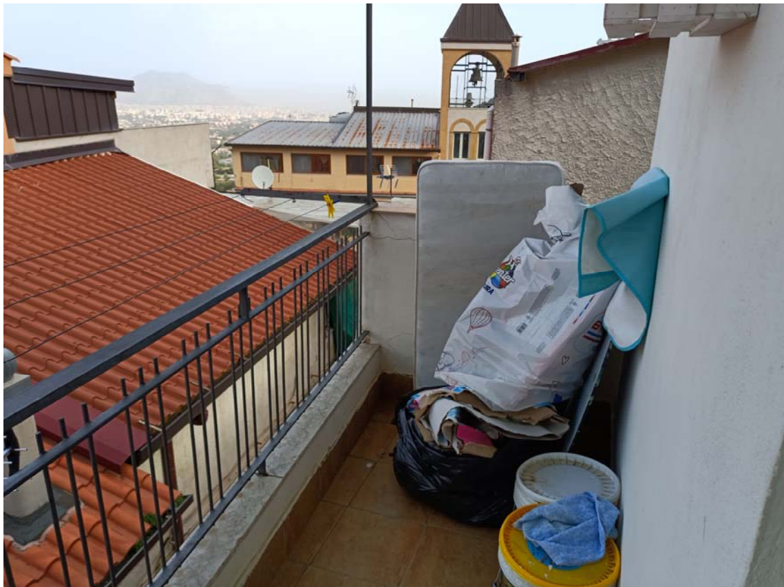
Immagine n. 15 – Vista del ballatoio prospiciente il cortile
