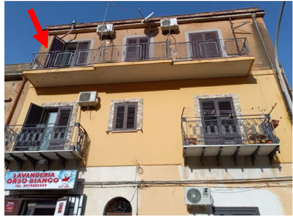
Immagine n. 14 – Vista del ballatoio su via Altofonte
