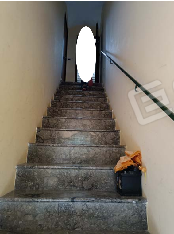
Foto n. 3 – Vista del corpo scala
