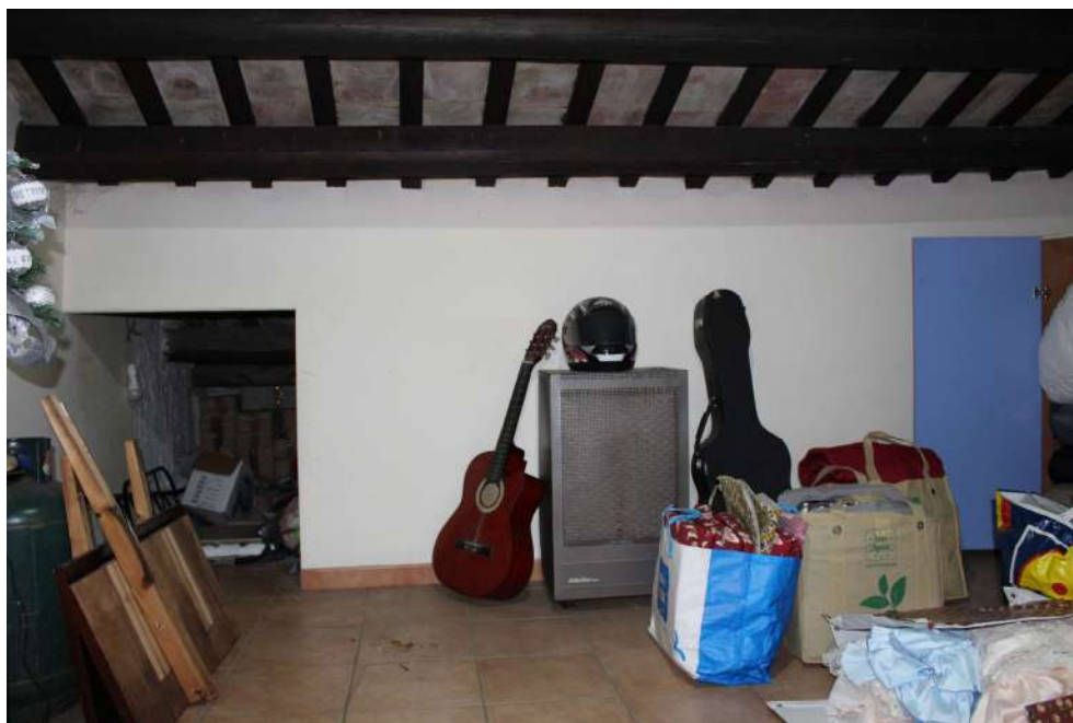
FOTO nn. 42, 43: PIANO SECONDO, Soffitta.
