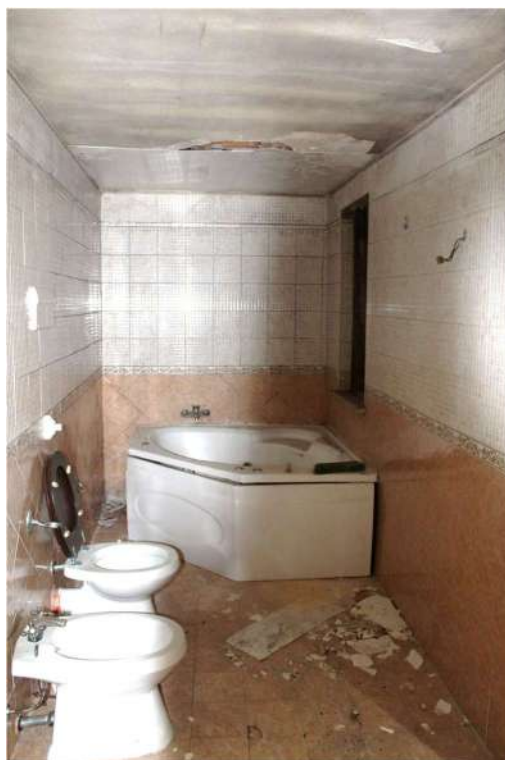
FOTO nn. 37, 38, 39: PIANO SECONDO, wc vasca (Vano14).
