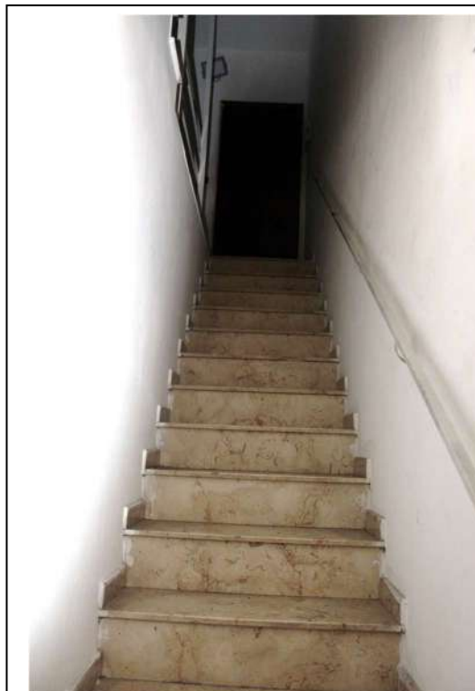
FOTO n°2: Vano scala con accesso dal civico 500
