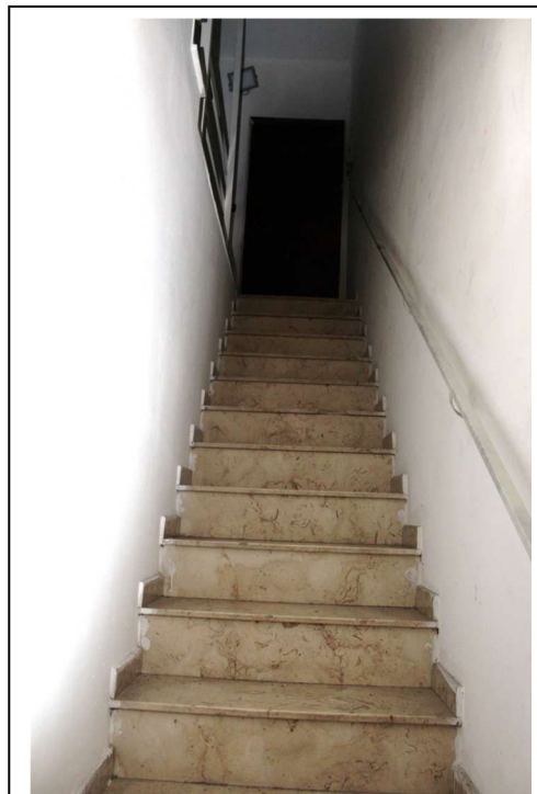
Corpo scala con accesso dal civ. 500.
