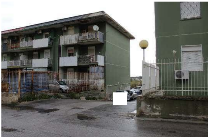
Strada di accesso dalla via Ciaculli
