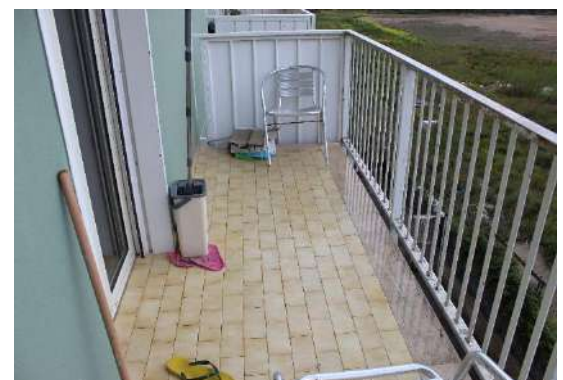
Vista del balcone su fronte principale
