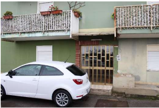
Ingresso scala A
