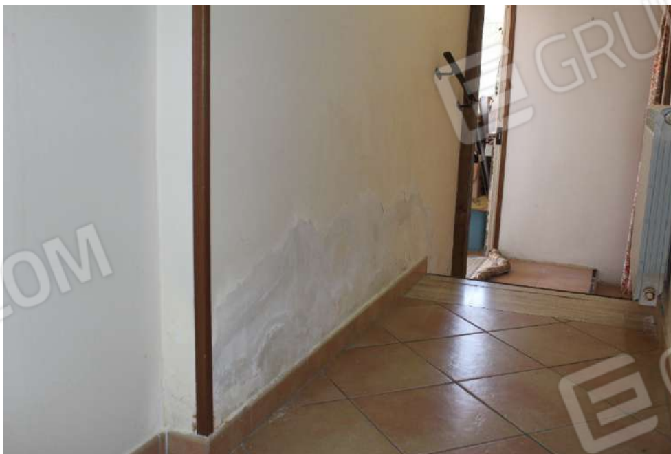
FOTO 42: UNITA' "A": Muratura che separa vano 7 dal vano 5
