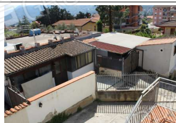
FOTO 4: Area di accesso comune.
