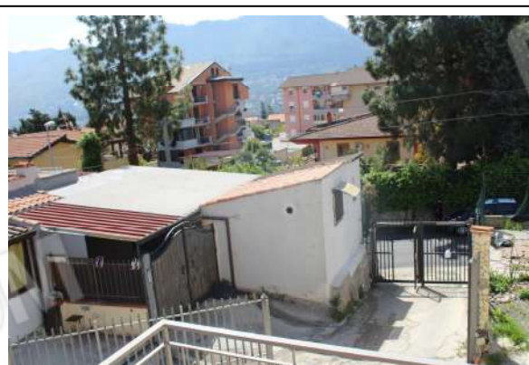
FOTO 3: Area di accesso comune.
