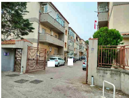
Foto 1: Vista ingresso su via Agnetta civ. 134
