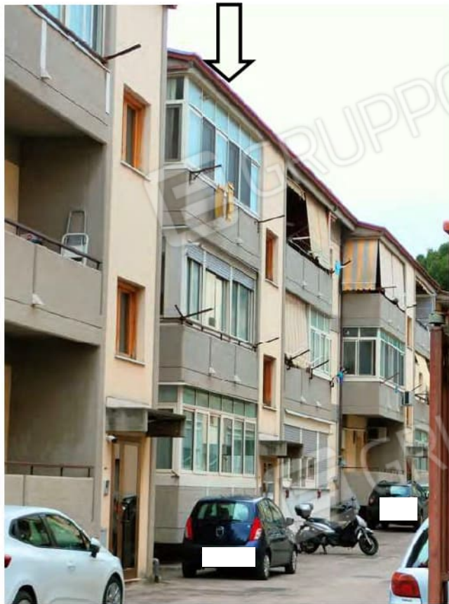
Foto 2 - Vista prospetto immobile su atrio comune (Scala B)
