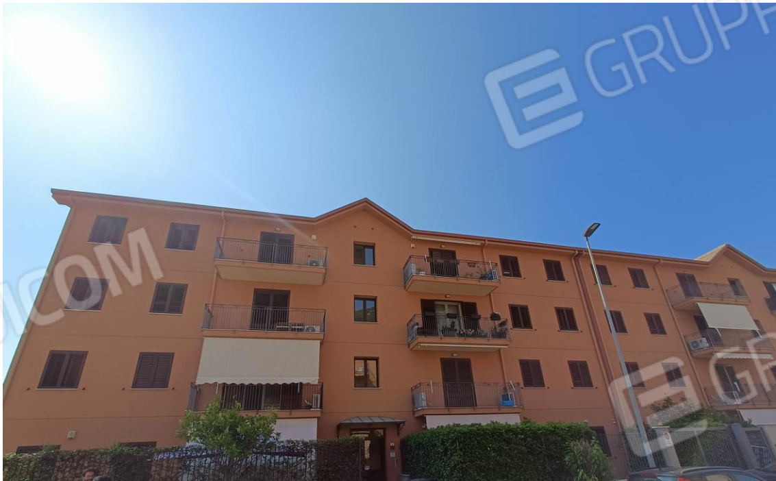
Foto n. 3. Vista della palazzina in cui si trova l'appartamento
