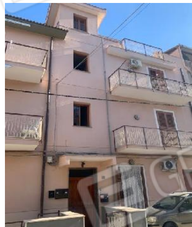
Edificio in oggetto
