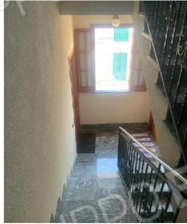
Scala comune edificio
