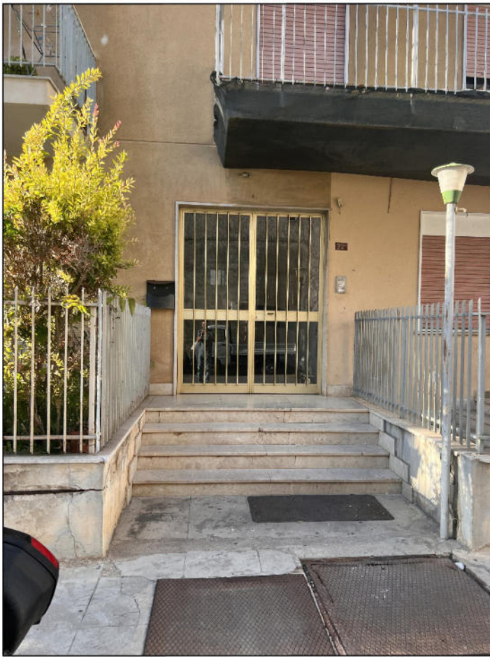
viste accesso e androne condominiale
