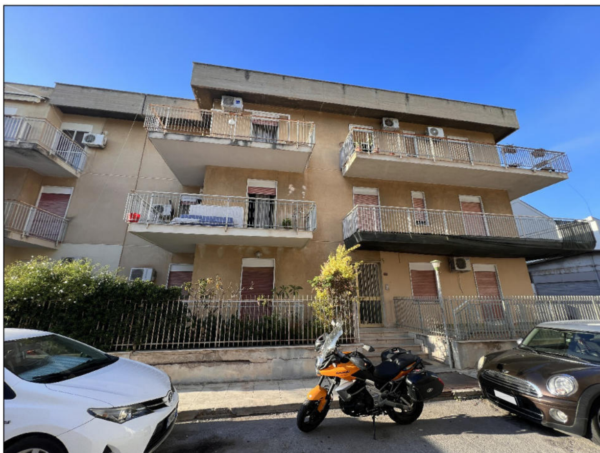
vista scala A da cortile condominiale
