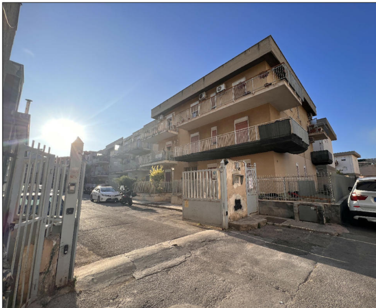
vista complesso condominiale da via Buzzanca
