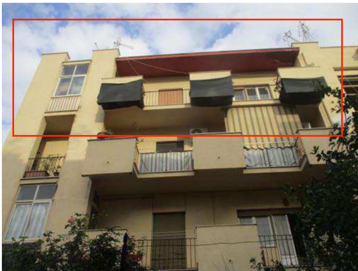
Foto 2- vista dell'appartamento pignorato a piano terzo sx
