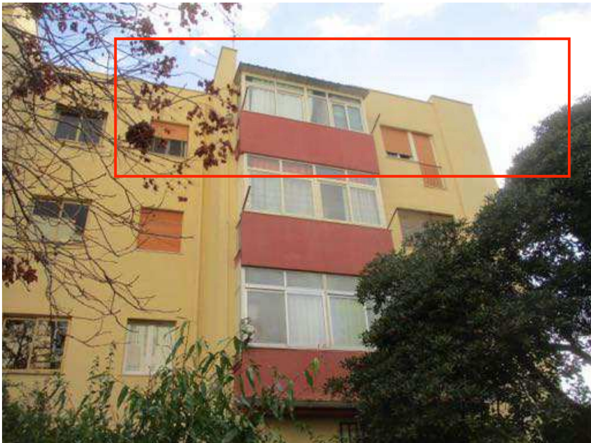
Foto 4- vista dell'appartamento pignorato a piano terzo sx
