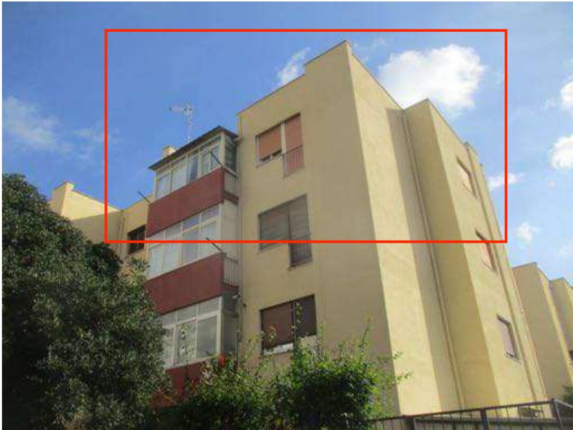
Foto 3- vista dell'appartamento pignorato a piano terzo sx
