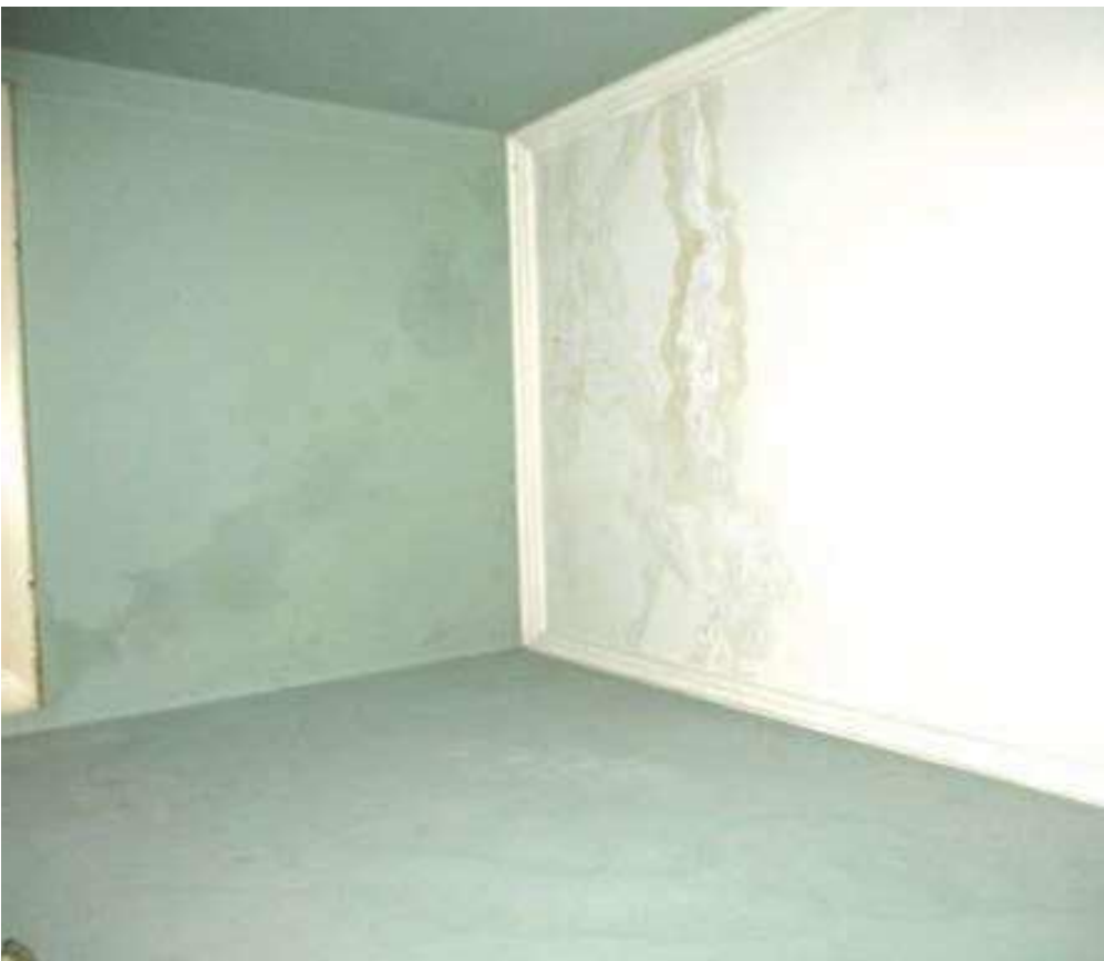
Foto 10- particolare del corridoio
