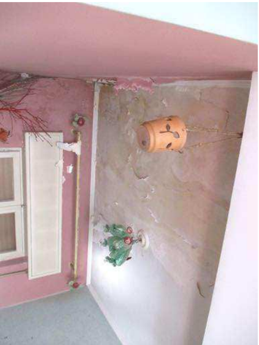
Foto 7- particolare del soffitto del locale ingresso-soggiorno
