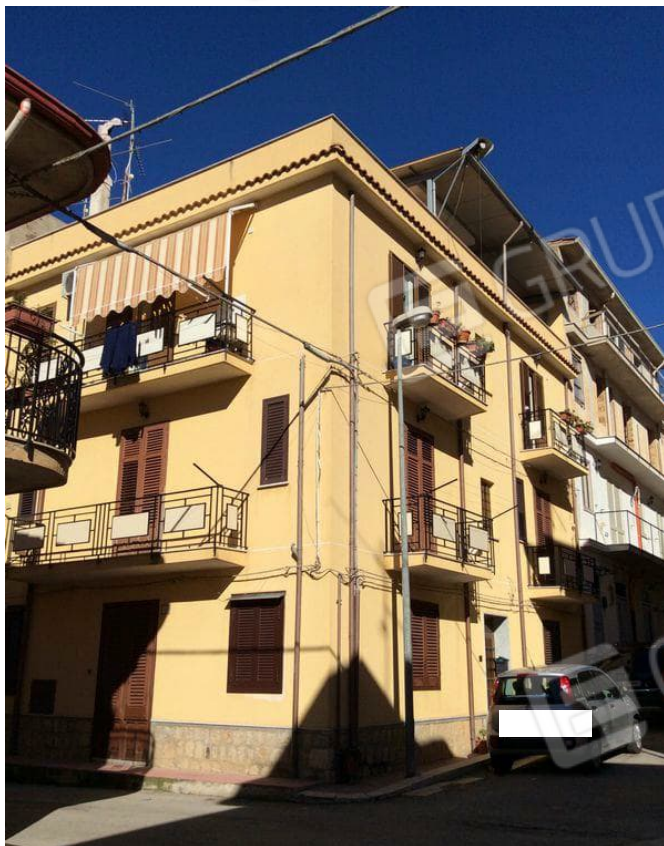
FOTO 3 – Prospetti sulla via S. Agostino e via Ragusa
