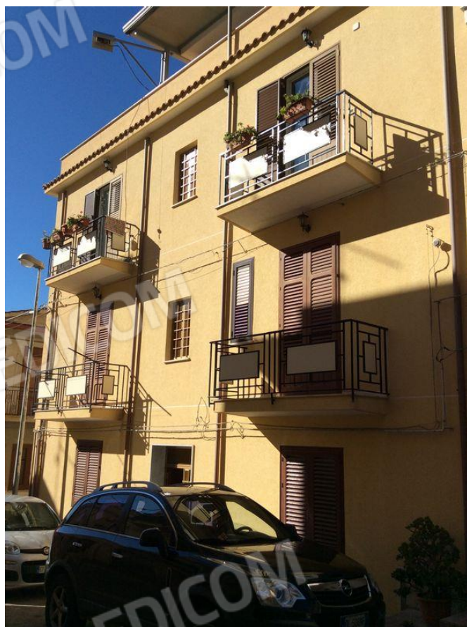
FOTO 4 – Prospetto sulla via Ragusa
