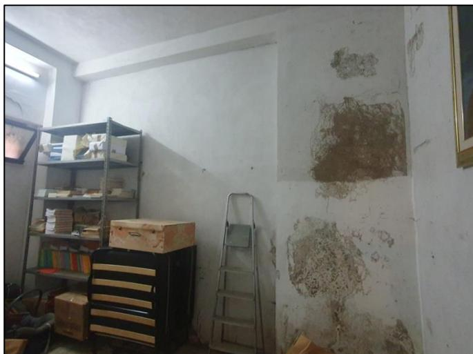
Foto 23– Tracce di infiltrazioni sul pilastro
