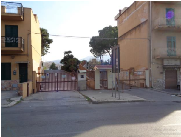
Ingresso complesso condominiale
