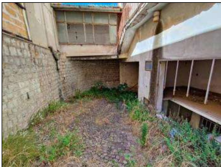
Rampa di accesso al piano cantinato
