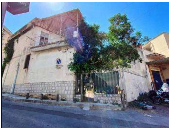
Accesso al complesso edilizio dal civ. 64 e 66 di via Buonriposo
