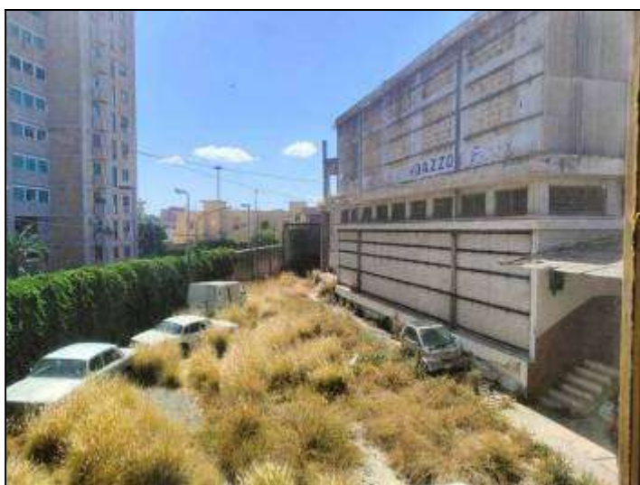
Corte scoperta di pertinenza
