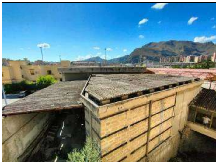
Copertura in ethernit della cella frigorifera trapezoidale e della tettoia
