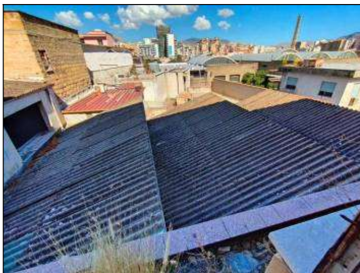
Copertura in ethernit di una porzione del corpo "A"
