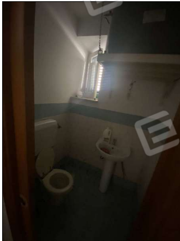
Foto 7,8: vano unico e w.c.
