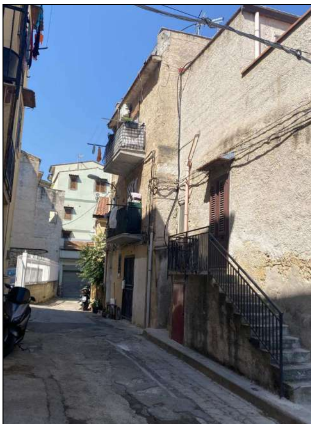
Prospetto esterno: Immobili lotto A e B: via Canzonieri civ. 4 - 6 piano T – 1° e 2°
