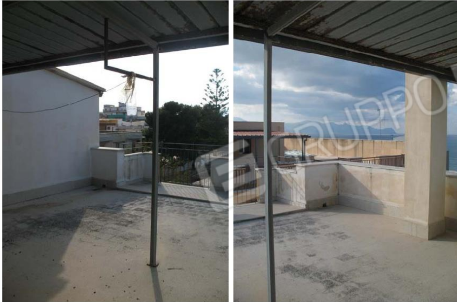
Foto n. 7 – Terrazzino prospiciente via Bommarito.
