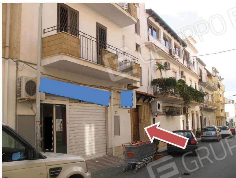
Foto n. 2 – Portone di accesso dalla Via Bommarito,27
