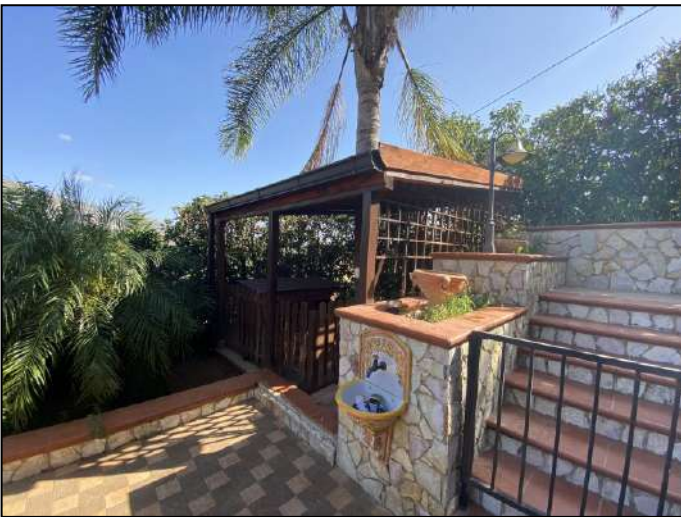
Tettoia presso la corte lato nord
