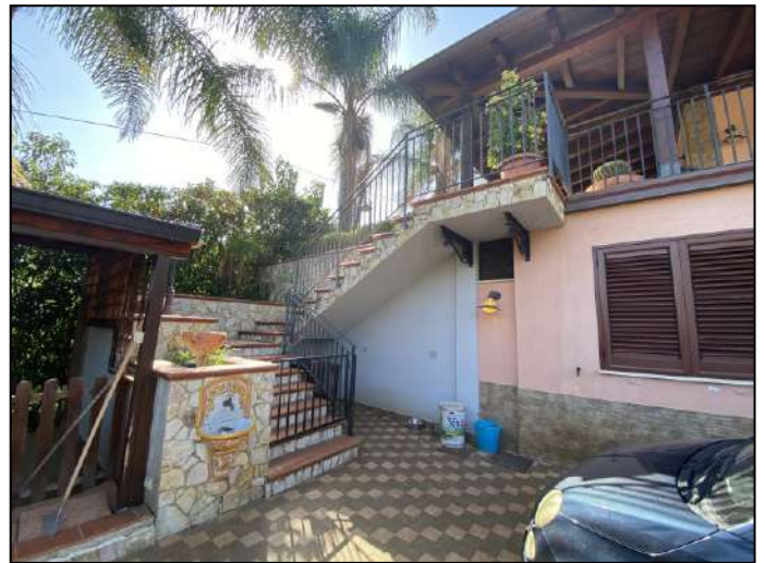
Scala di accesso al piano terra
