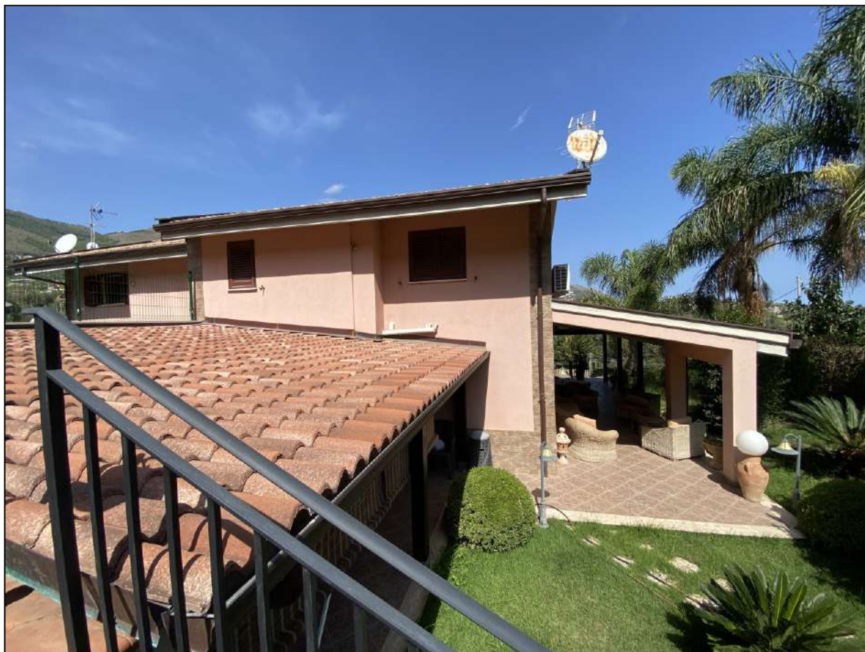
Fabbricato residenziale: vista del prospetto sud
