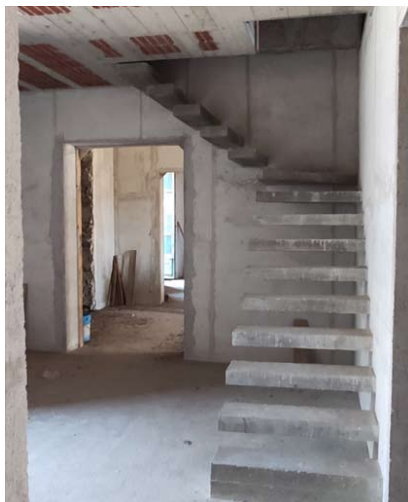
Foto n. 29: Il vano 5. La scala che conduce al piano sottotetto.
