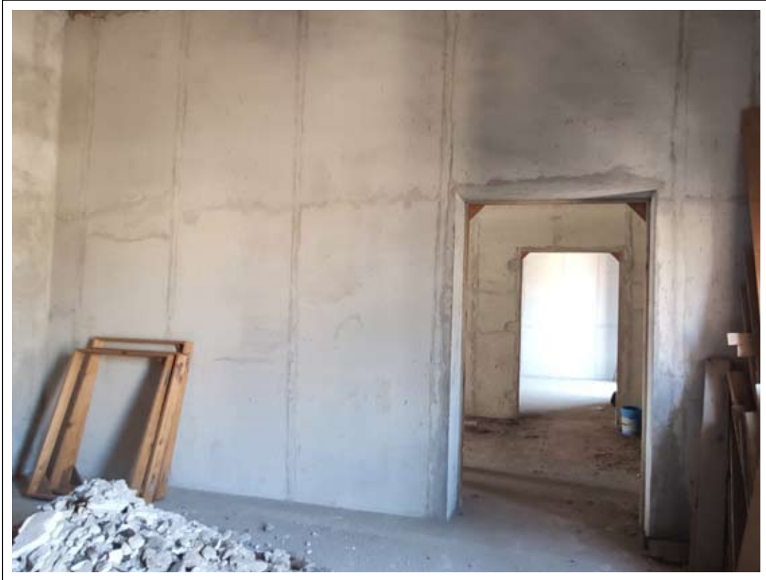
Foto n. 25: Il vano 3. Vista verso il vano 4 e 5.
