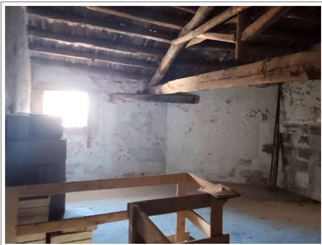
Foto n. 36: Il vano 7, al piano mansarda-sottotetto.
