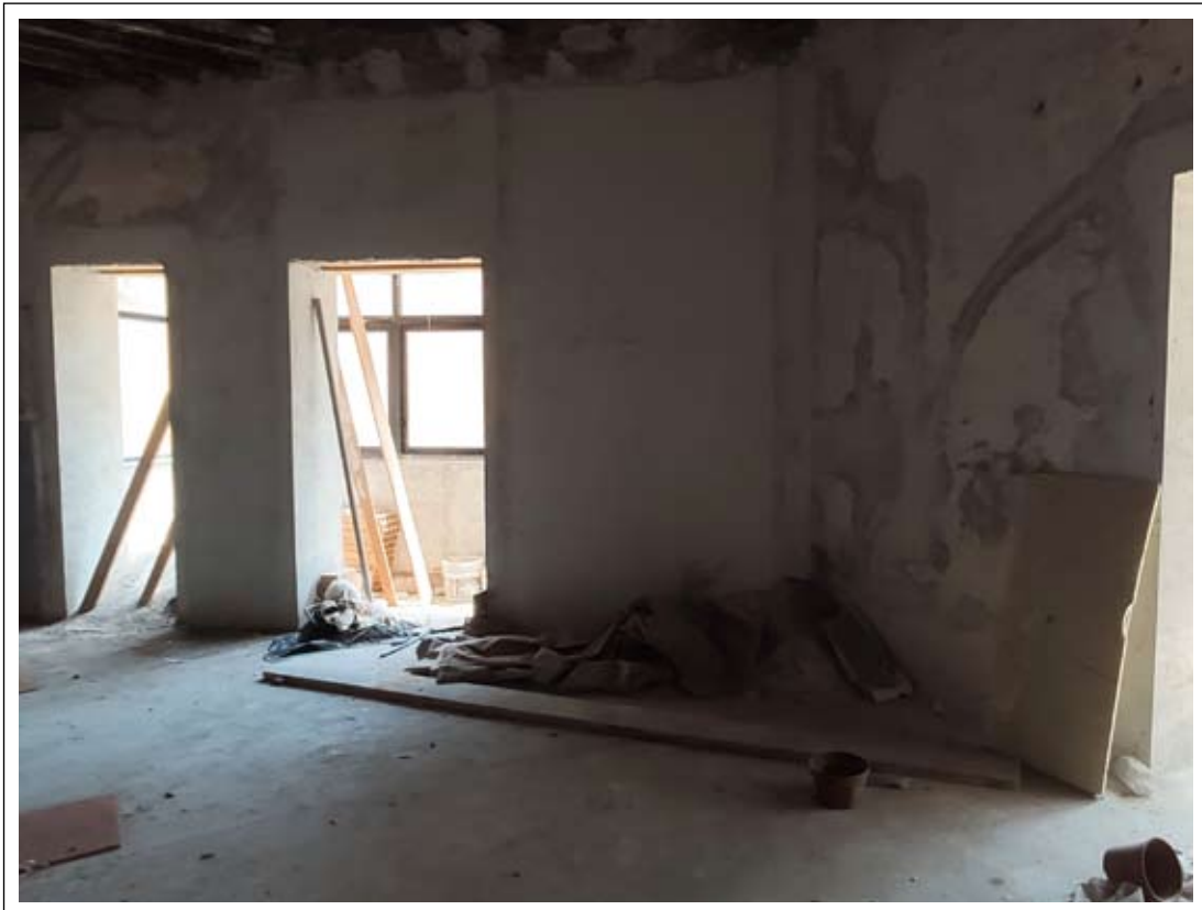
Foto n. 14: Vano 1: i varchi verso il corridoio-veranda.
