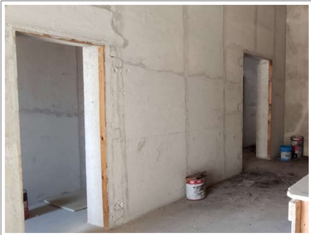
Foto n. 26: Vano 4. A sinistra l'accesso al wc 1, a destra il passaggio verso il vano 5.
