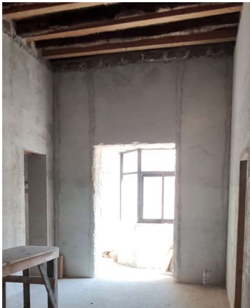
Foto n. 24: Il vano 4. Vista verso il corridoio-veranda.
