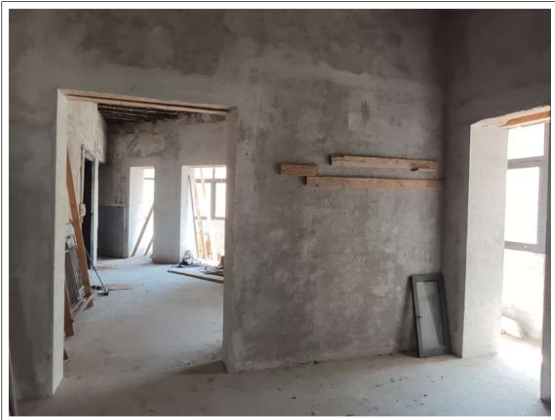
Foto n. 20: Il vano 2. Vista verso il vano 1.
