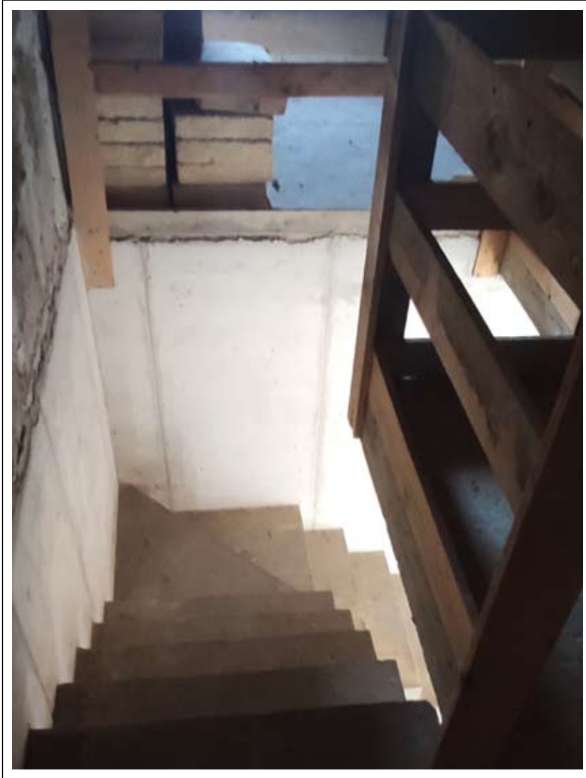
Foto n. 35: La scala di collegamento vista dal piano sottotetto.
