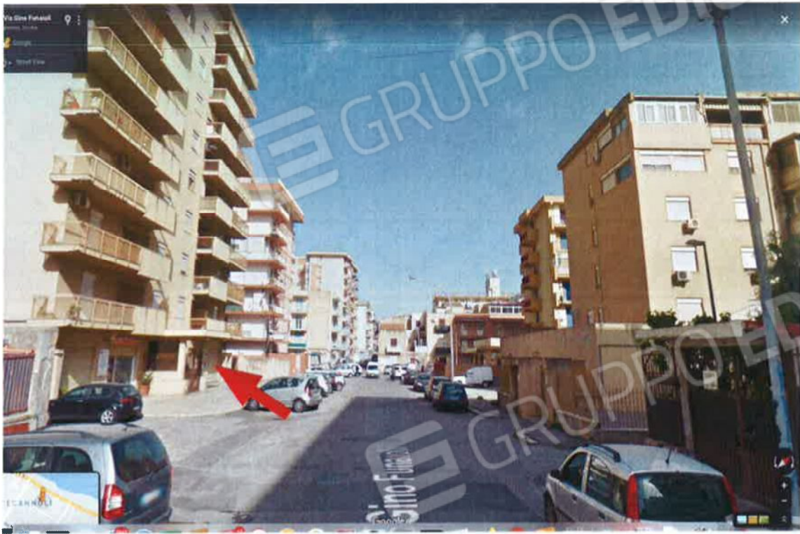
Fig.3: Individuazione del fabbricato lungo via Gino Funaioli: vista verso nord-ovest
