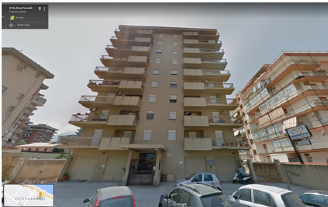
Fig. 6: Fronte principale del fabbricato prospiciente via Gino Funaioli
