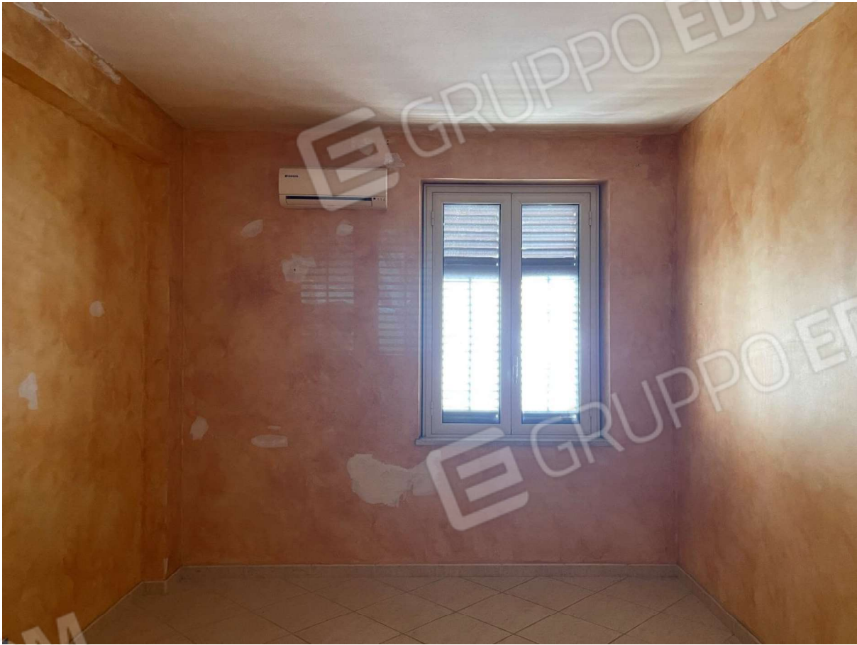
Foto 15 – La camera da letto matrimoniale con pompa di calore
