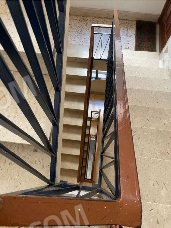
Foto 3 – Il vano scala senza ascensore
