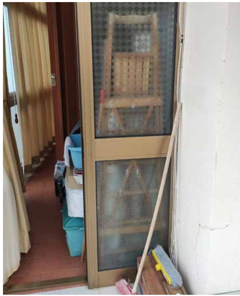
Foto nn. 17 - 18: La veranda. Uscita verso il balcone.
