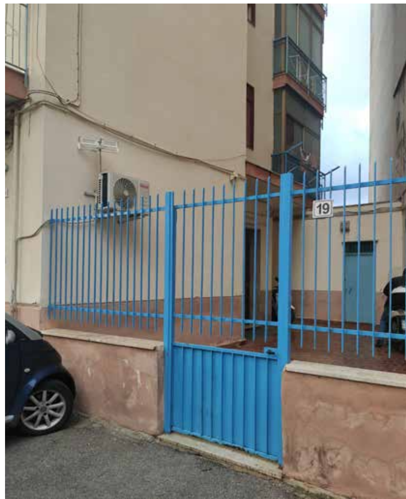
Foto nn. 1 - 2: L'accesso all'edificio.
