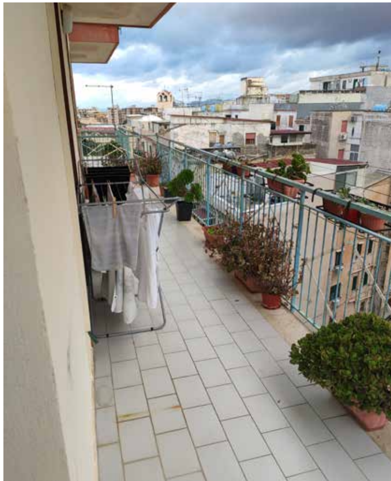
Foto n. 19: Il balcone prospiciente la via Favignana.
