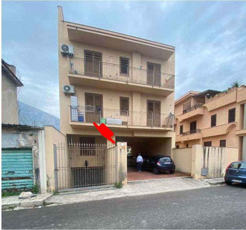
Figura 2.b– Figura 2.b–Vista dell'ingresso al box auto sito in via Guerrino Miglioranzì snc
