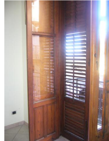
Fig. 22 Particolare infisso esterno.
