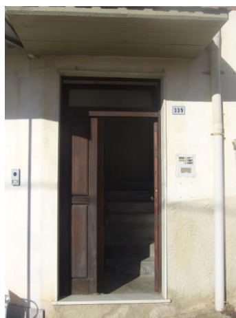
Fig. 10 Ingresso alle unità civ. 339.
