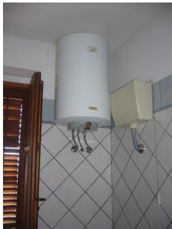
Fig. 23 Boiler elettrico.
