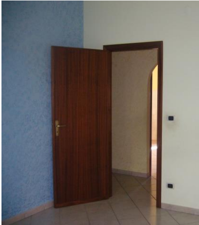
Fig. 20 Particolare parete e porta interna.
