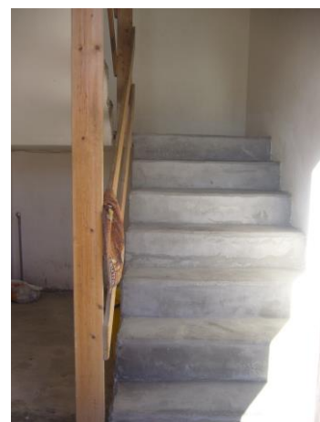
Fig. 11 Vano scala condominiale.
