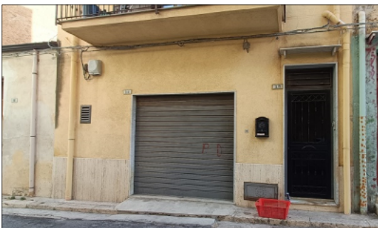
Ingressi all'immobile dai civv. 12-14
