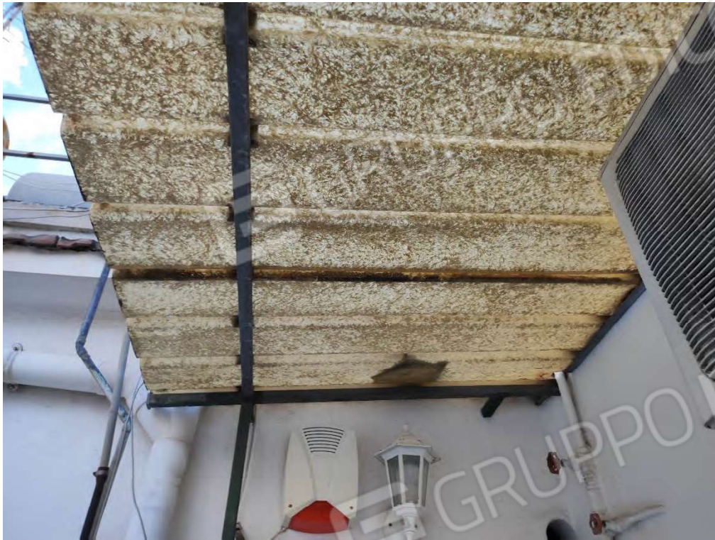
FOTO N. 29 – Tettoia su balconcino della cucina
