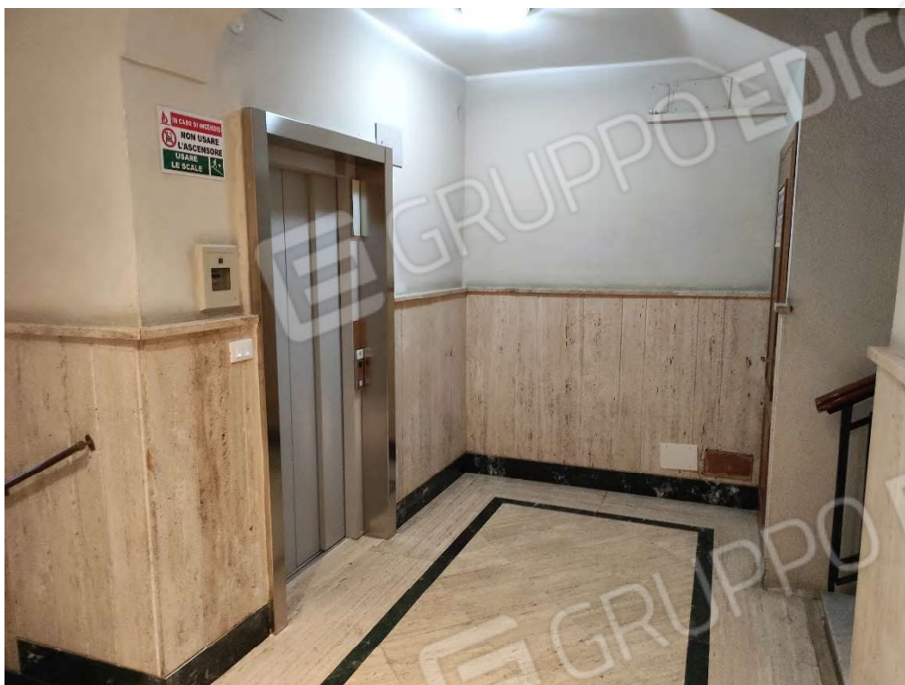
FOTO N. 3 – Vista dell'ascensore condominiale
