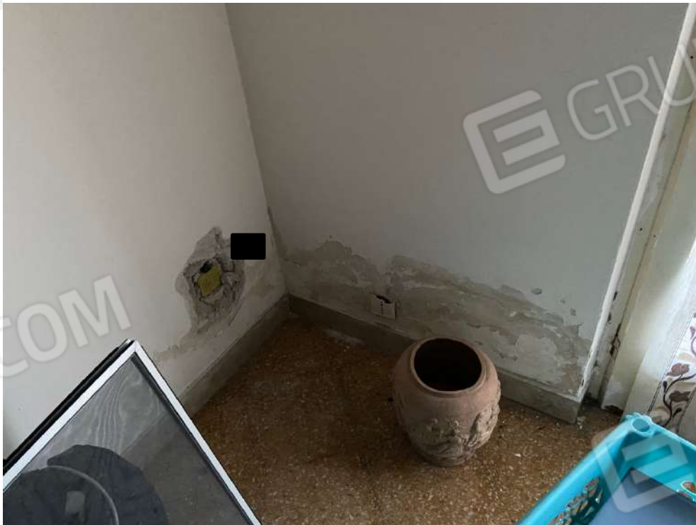
Foto n. 8 – intonaci ammalorati
