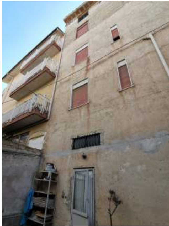
Immobile Piano terra – vista del prospetto NE
