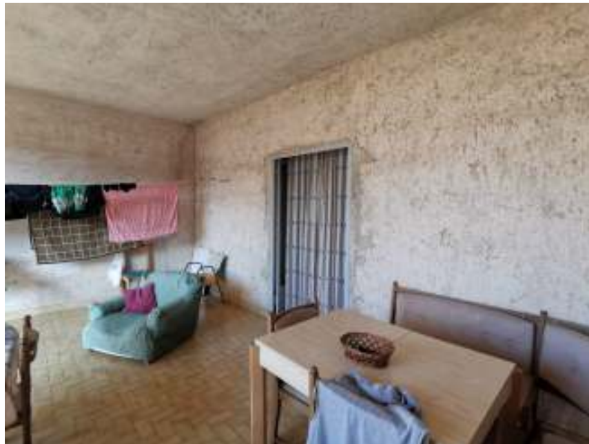
Piano terzo – vista della veranda verso il vano soggiorno letto
