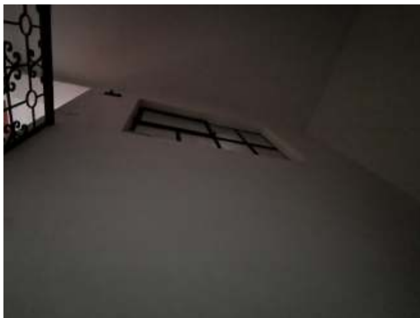
Piano terzo – finestra aperta sul vano scala dall'appartamento
