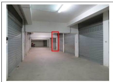
Fig. 24. Primo piano seminterrato. Box auto pignorato identificato al sub. 46 (indicato col riquadro rosso)
