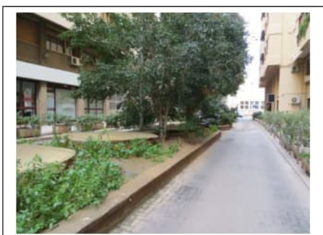
Fig. 8. La via Villa Heloise. Lucernari che illuminano il primo piano seminterrato
