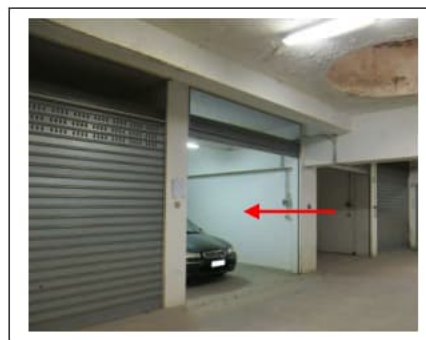
Fig. 25. Primo piano seminterrato. Box auto pignorato identificato al sub. 46 (indicato con la freccia)
