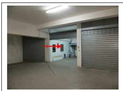
Fig. 24. Primo piano seminterrato. Box auto pignorato identificato al sub. 49 (indicato con la freccia)
